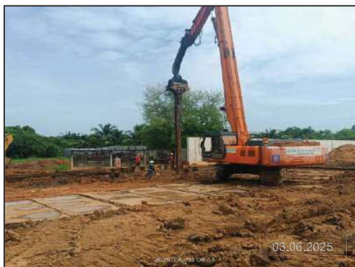
จ) กิจกรรมการติดตั้ง Sheet Pile ในการเตรียมบ่อรับ
