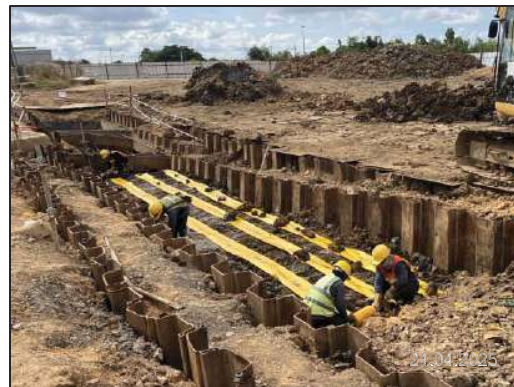
ค) กิจกรรมการวางแถบเตือนป้องกันการขุด จากบุคคลที่ 3 ก่อนการฝังกลบ
