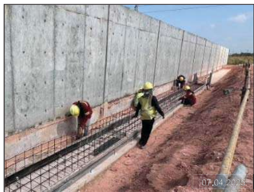
ง) กิจกรรมการก่อสร้างรางระบายน้ำภายใน สถานีควบคุมก๊าซฯ
